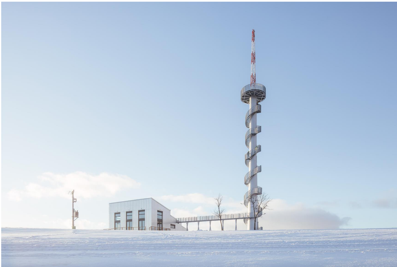
Nový Hrádek, rekonverze tubusu větrné elektrárny transformovaného na rozhlednu s turistickým infocentrem, zdroj: Královéhradecký kraj
